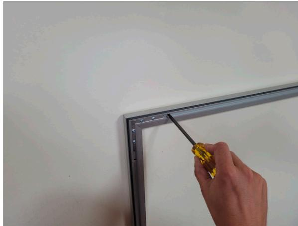
Den zusammenmontierten Profilrahmen durch die Befestigungslöcher an die Wand schrauben.
