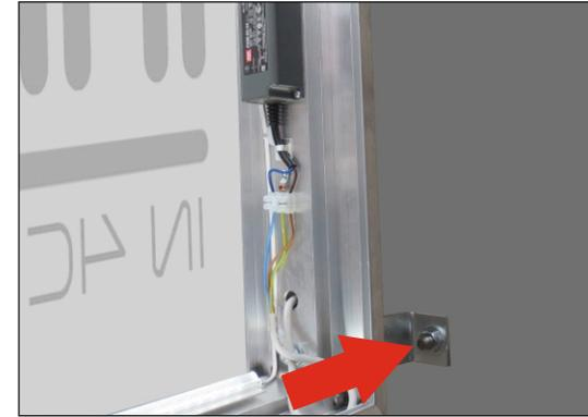
Schild mittels Konsolen an die Wand montieren. Befestigungsmaterial je nach baulichen Gegebenheiten wählen. Darauf achten, daß sich die Wasser-Ablaufbohrungen an der **Unterseite** des Schildes befinden!
