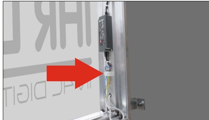
230V Anschlussleitung anschließen und Pressverschraubung fest verschließen. Nicht benötigte Bohrung mit mitgeliefertem Stoppel verschließen!
